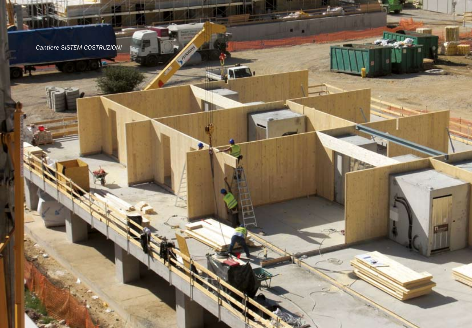
Cantiere SISTEM COSTRUZIONI
