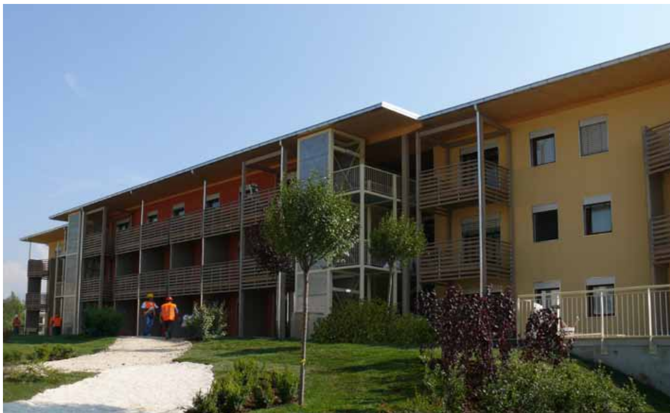
Figura 1 - Edificio finito - Cese di Preturo 28/09/2009
